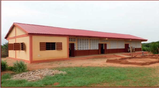
Das neue Schulgebäude in Adjedacope
