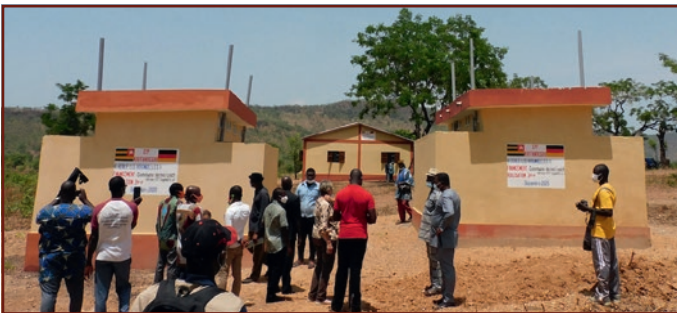
Die neuen Latrinen in Koutandiégou
