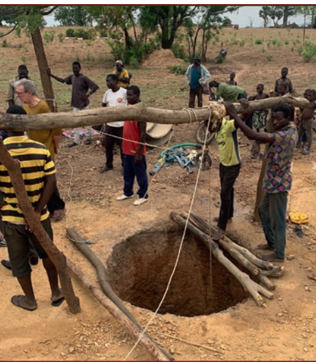
Brunnenbaustelle im Tambermatal
